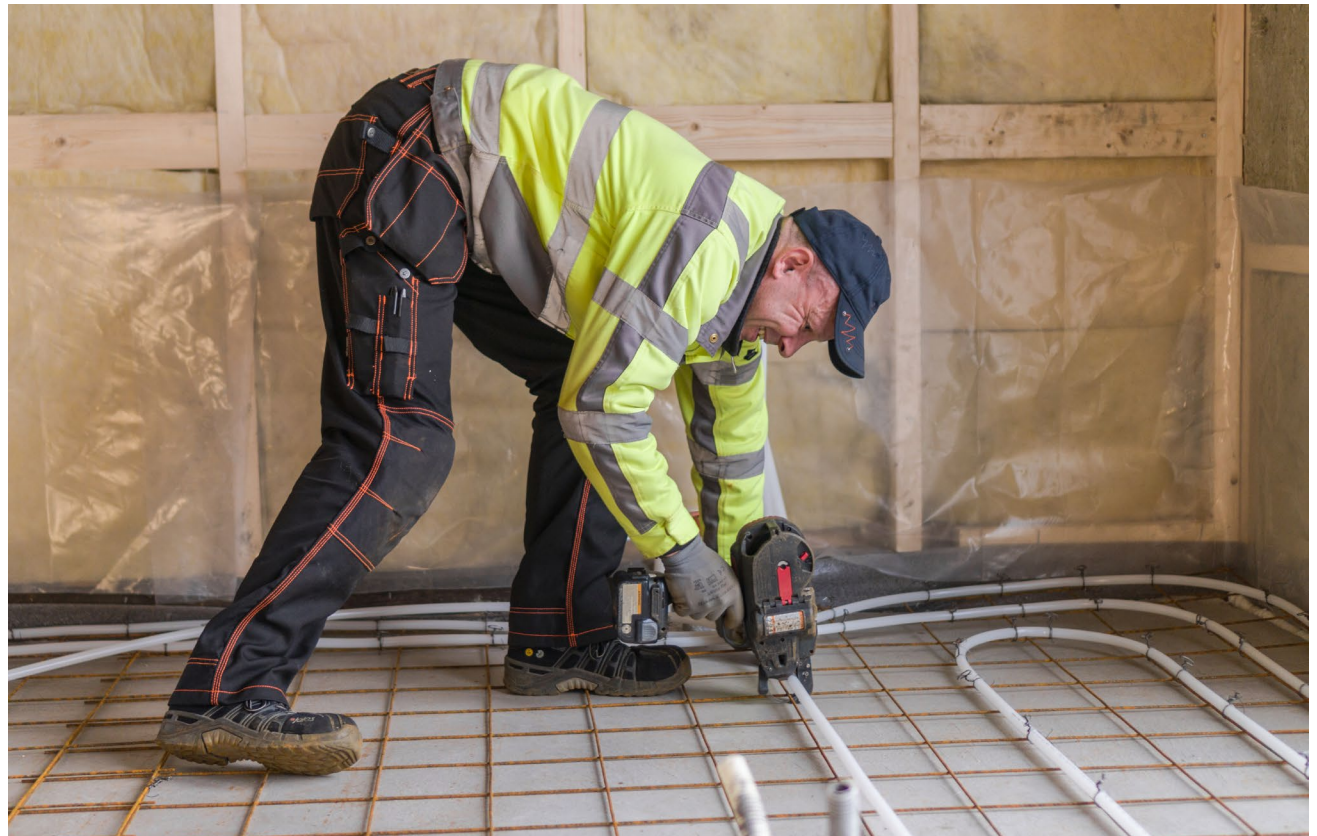
Lattialämmityksen asentaminen.
